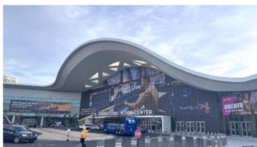
ラスベガス・コンベンションセンター(LVCC)
